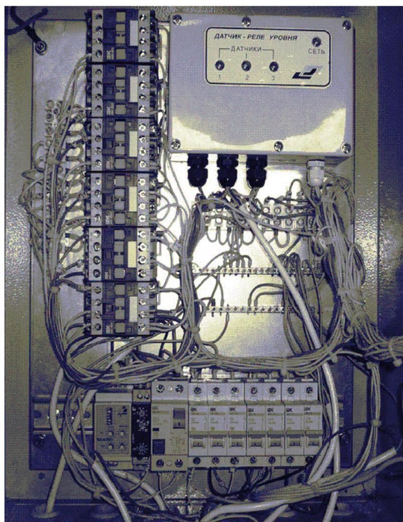
*Рис. 2.4.9. Подсоединение автоматических выключателей и УЗО*
