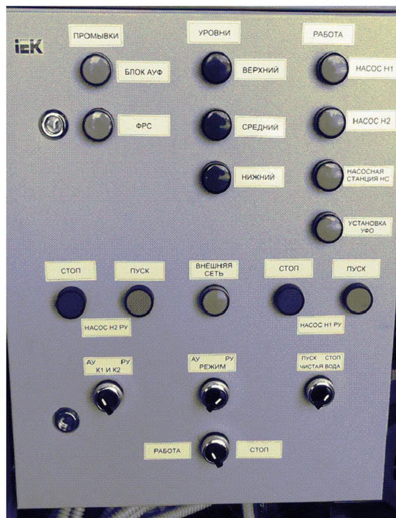
*Рис. 2.4.10. Пульт автоматического и ручного управления*
