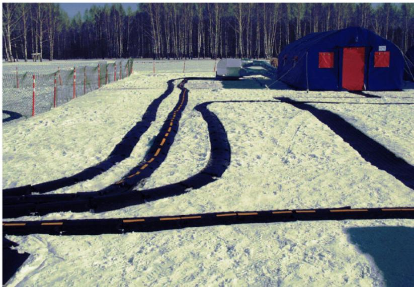
*Рис. 2.3.3. Общий вид кабель-каналов системы энергоснабжения на территории ПВР*
