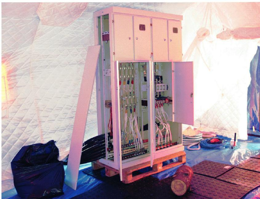
*Рис. 2.3.2. Общий вид электрораспределительного щита*
