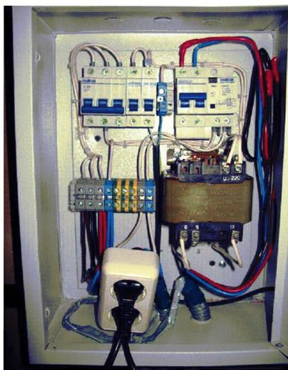
*Рисунок 2.3.4. Общий вид электроподключения через щиты защитного отключения*
