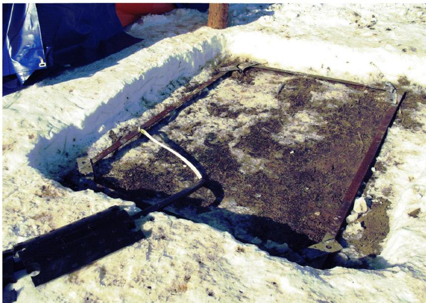
*Рис. 2.3.6. Заземляющее устройство дизель-генераторной установки*
