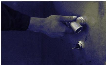
*Рис. 2.4.5. Наворачивание угольника 1"*
