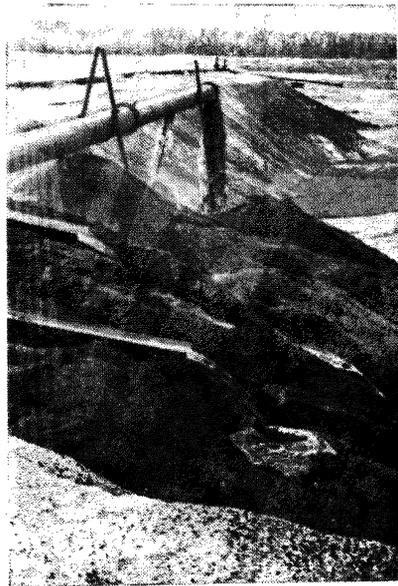
Рис. 1-1. Намыв ограждающей дамбы на отвале Тихвинского завода.
