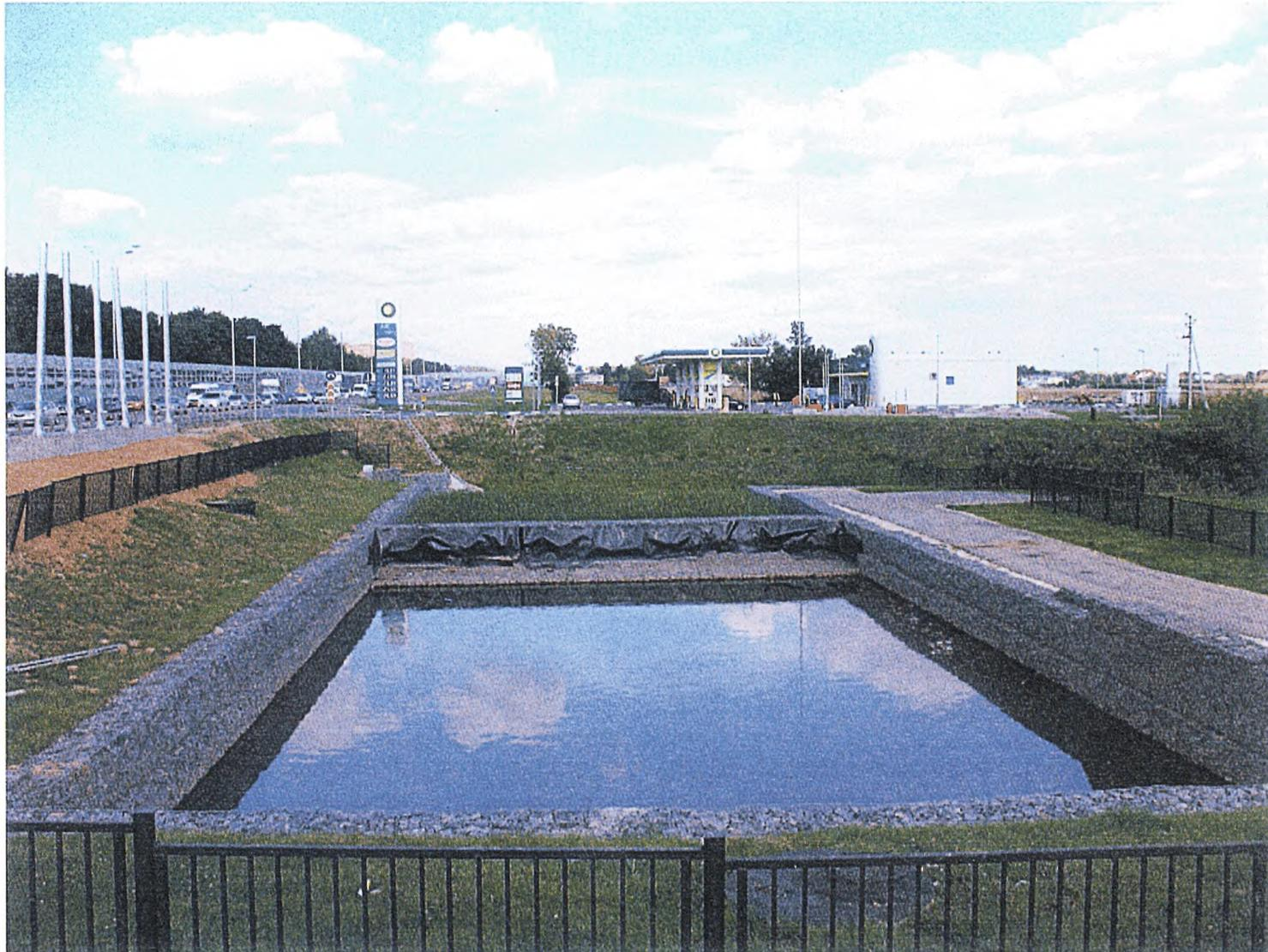
Рис. 4.1.6. Очистное сооружение каскадного типа с использованием габионов (вид сверху)
