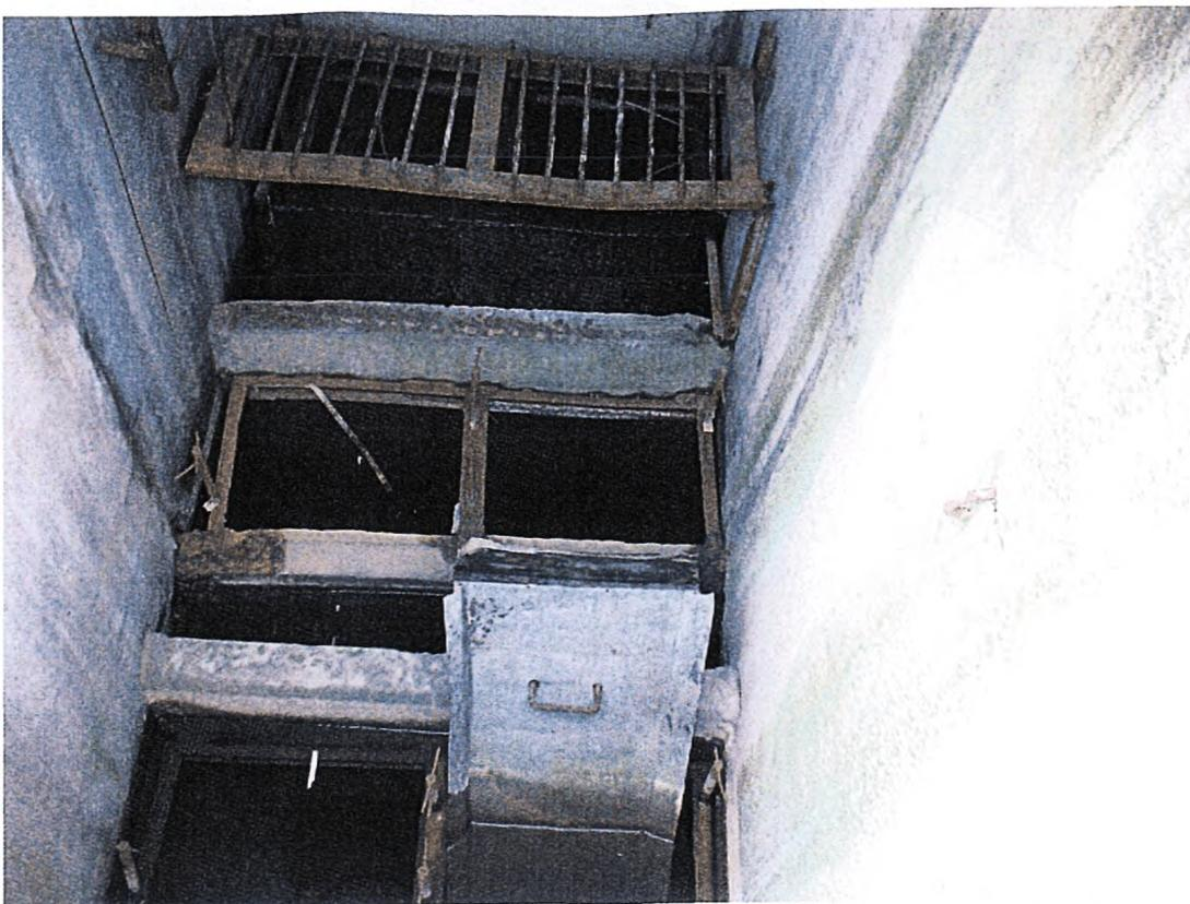
Рис. 4.6.4. Очистное сооружение индивидуального проектирования кассетного типа (секция очистки ливневых сточных вод)
