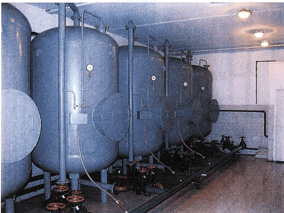
Рис.4.3.4. Очистное сооружение индивидуального проектирования (фильтры 1-3 ступеней очистки)
