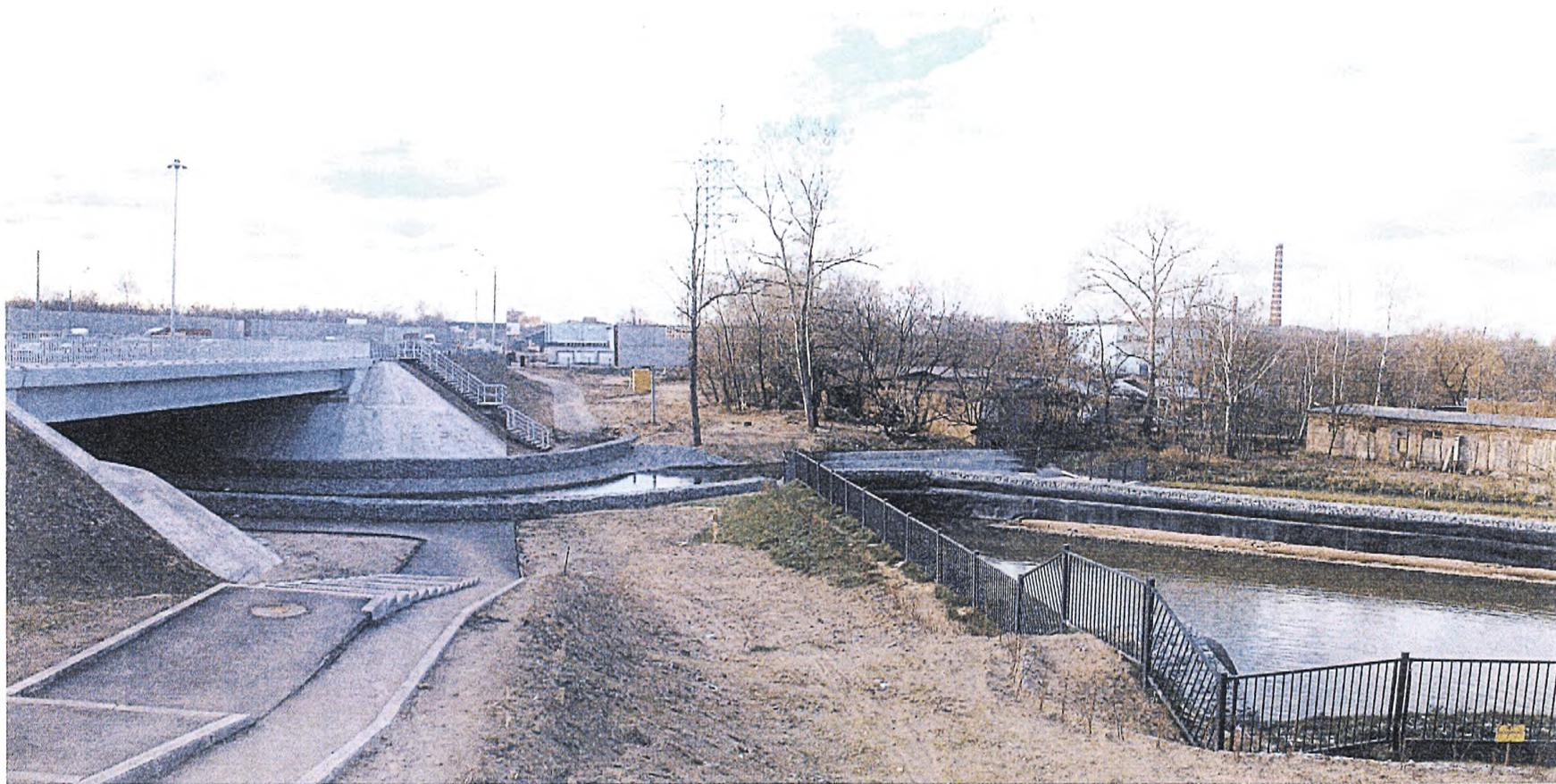
Рис. 4.1.8. Очистное сооружение (пруд-отстойник каскадного типа)
