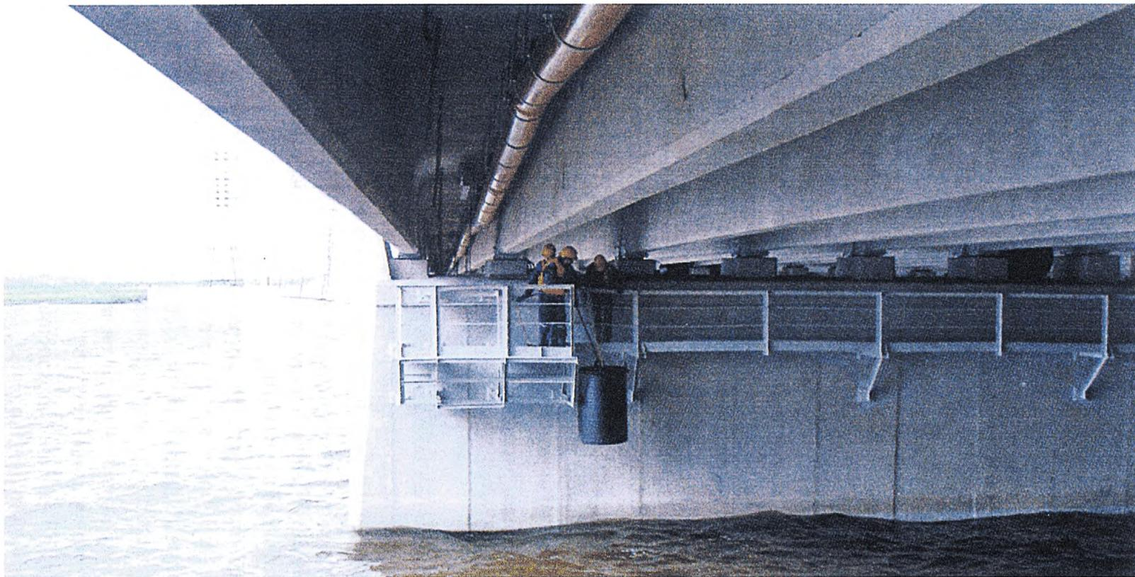
Рис.4.7.3. Комбинированный фильтрующий патрон (установка на опоре моста)
