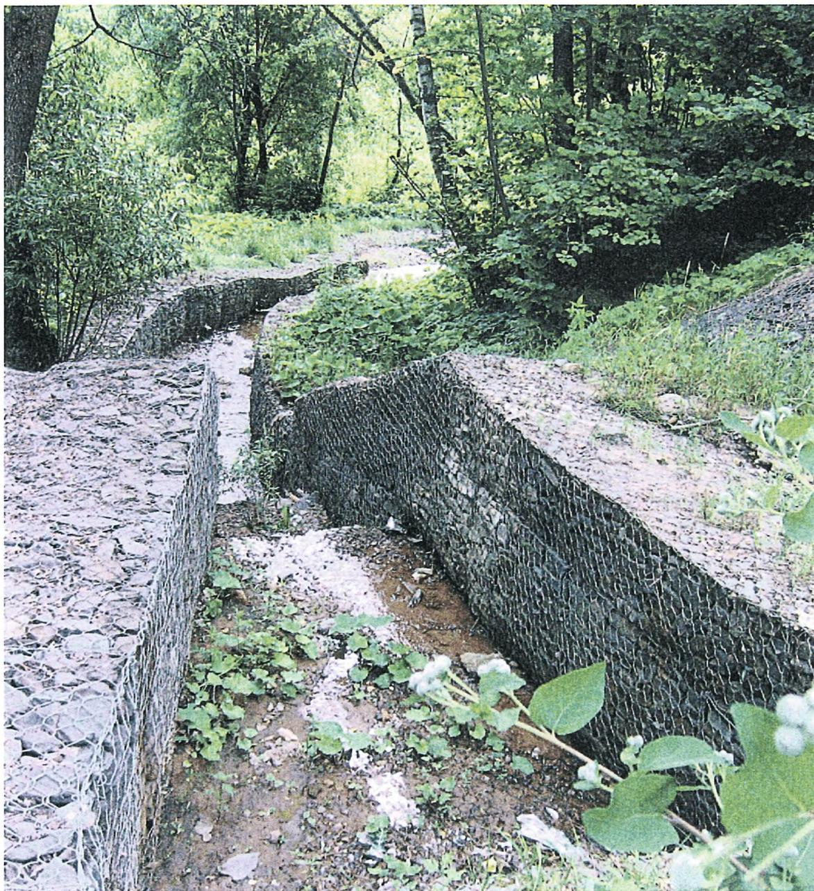
Рис. 4.6.5. Лоток сброса очищенных стоков на рельеф местности
