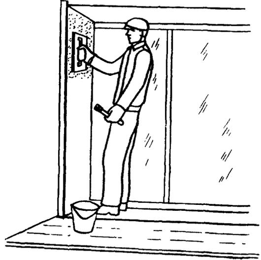
Подготовив раствор, штукатуры Ш<sub>20</sub> и Ш<sub>22'</sub>, Ш<sub>21</sub> и Ш<sub>23</sub> кельмами набирают его из ящика на соколы и наносят на откосы. Затем они выравнивают и затирают терками поверхность откосов, периодически смачивая их водой. Вертикальность и горизонтальность выровненной поверхности штукатурки проверяют с помощью отвеса, угольника и уровней
