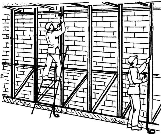
2-4 ПОДНОСКА ПЛИТ, ПОДБОР ИХ ПО РИСУНКУ И ОТТЕНКУ; ПОДГОНКА ПЛИТ ПО МЕСТУ; 268 мин; С<sub>1</sub>, С<sub>2</sub>; молоток, отвес, лестницы, дисковая пила, электродрель
