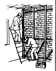
редине рам, столяры окончательно устанавливают в вертикальное положение рядовые рамы каркаса и закрепляют их
