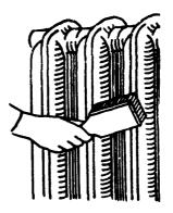
Маляр, работая шпателем как скребком, легкими скользящими ударами снимает с металлических поверхностей отвердевшие брызги раствора и окалину.
