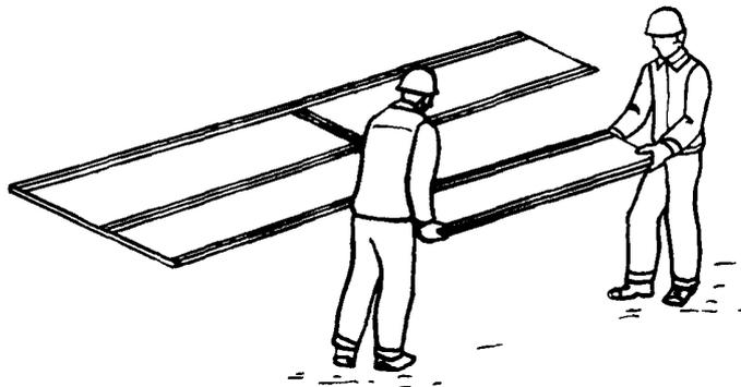
Слесари С<sub>1</sub> и С<sub>2</sub> строят пакет щитов, подают команду машинисту крана переместить его к месту сборки, а сами переходят туда же, берут щиты из пакета и раскладывают их рабочими поверхностями вниз. В местах пропуска стяжек между щитами они прокладывают деревянные рейки
