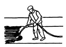
Бетонщик Б<sub>4</sub>, поддерживая левои рукой шланг снизу, правой держит его у выходного отверстия и наносит на основание раствор параллельными полосами шириной 30-40 см. Бетонщик Б<sub>3</sub> переносит шланги
