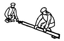
Бетонщики  $B_1$  и  $B_2$  укладывают маячную рейку на маяки из раствора, проверяя правильность укладки по уровню, и закрепляют ее с обеих сторон раствором
