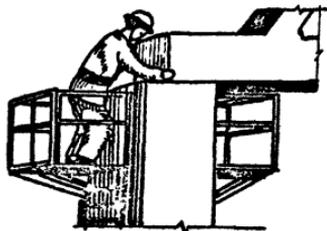
$M_1$  и  $M_3$ , стоя на площадке одной лестницы, а монтажник  $M_2$  - на площадке другой, наводят ферму на место установки, совмещают риски на ферме с рисками на колонне и опускают ферму с помощью крана на колонны.
