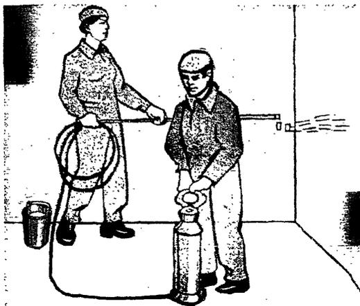
Рисунок 10 – Оштукатуривание поверхности стен краскопультом
