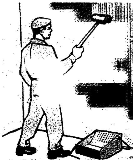
Рисунок 11 – Оштукатуривание поверхности стен валиком
