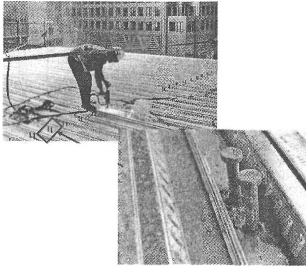
Рисунок 15 – Установка стэд-болтов в перекрытии с помощью пистолета
