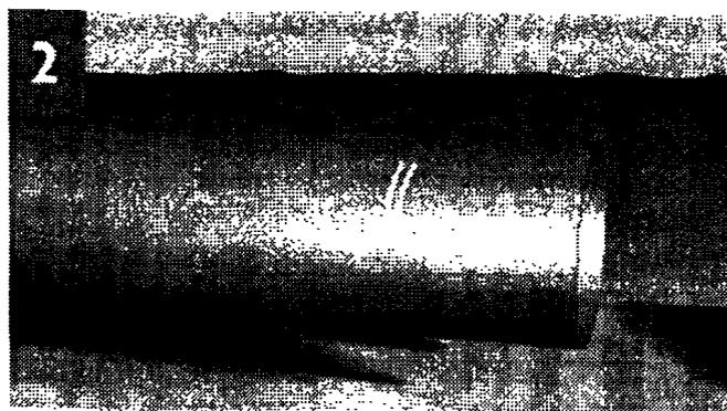
Нанесение линии ограничения на гладком конце трубы
