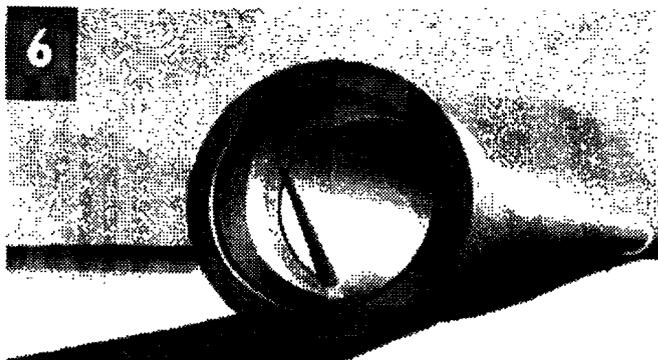
Смазка внутренней поверхности уплотнительного резинового кольца
