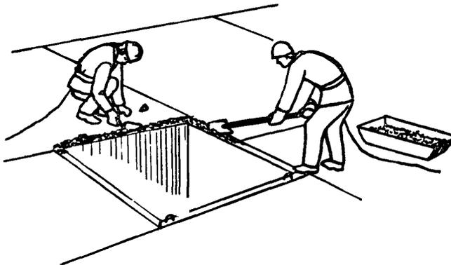
Монтажники  $M_1$  и  $M_2$  при необходимости очищают и смачивают водой место опирания блока, затем подают лопатами раствор из ящика (держа при этом лопаты наклонно), раскладывают его по верхним граням блока и разравнивают раствор кельмами. Затем они втапливают в раствор клинья для последующей выверки блока
