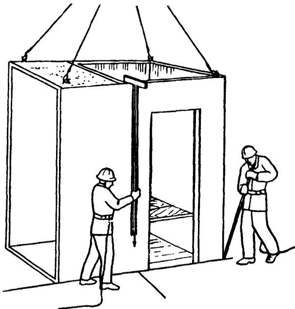
Незначительные отклонения по вертикали монтажник М<sub>2</sub> устраняет, осаживая завышенную сторону путем постепенного вытаскивания клиньев, для чего машинист крана К по его сигналу приподнимает, а затем опускает блок
