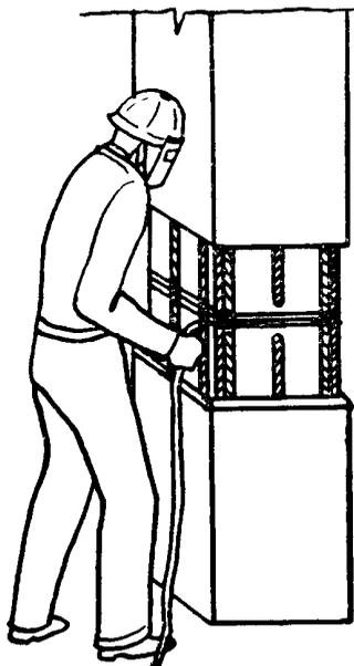
Монтажник  $M_1$  размечает места установки накладных стержней из арматурной стали, а монтажник  $M_2$  производит временное закрепление стержней электроприхваткой. До освобождения рамы от группового кондуктора монтажник  $M_2$  должен сварить примерно 60% стержней
