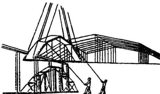
Монтажники М<sub>3</sub> и М<sub>4</sub> стропят двумя четырехветвевыми стропами собранную секцию свода, затем к монтажным петлям привязывают две оттяжки. После этого монтажник М<sub>3</sub> подает машинисту крана сигнал поднять секцию свода. При подъеме секции свода монтажники М<sub>3</sub> и М<sub>4</sub> удерживают ее от раскачивания пеньковыми оттяжками
