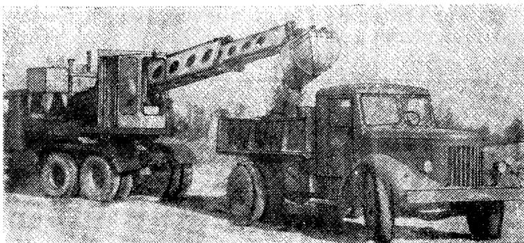
Рис. 8. Погрузка грунта экскаватором Э-4010 в автосамосвал
